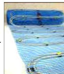
Danach wird die Bodenheizung mit Fliesmörtel eingegossen. Die Schichtstärke beträgt im Normalfall  $18 \text{ mm}$ . Nun kann der Deckbelag aufgebracht werden.
