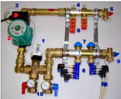
1. Einstellventil für die Vorlauftemperatur. Verbindung über Kapillarrohr zum Tauchfühler am Vorlauf. ==> 3
