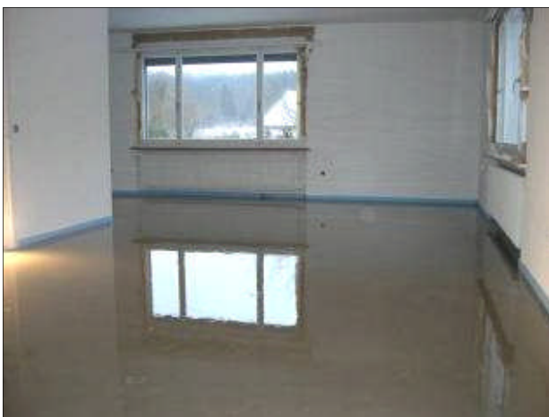
Nach 5 Stunden ist der Boden wieder begehbar
